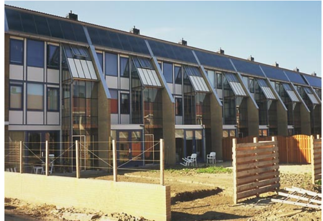
Zuidzijde tijdens de bouw van Veldzicht.
