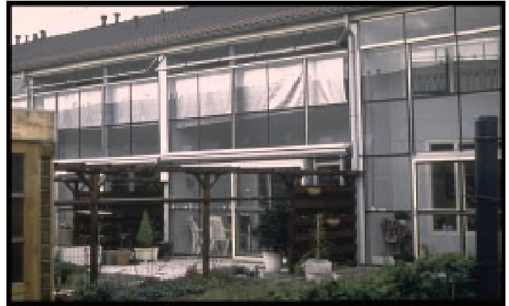
Zuidgevel woning in Spijkenisse
