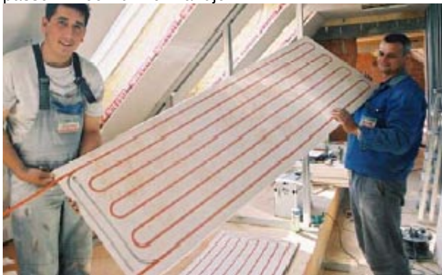
Prefab wandverwarming tijdens de montage.
